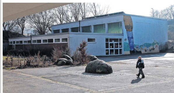
Die Sporthalle der Eichendorff-Schule in Kirschhausen: Der Heppheimer Finanzausschuss hat sich für einen Neubau gemeinsam mit dem Kreis Bergstraße ausgesprochen.
