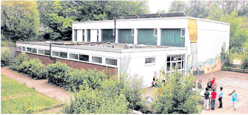
Ersatz in Sicht: Die zum Teil marode Turnhalle der Eichendorff-Schule in Kirchhausen soll durch eine 2,6 Millionen Euro teure, zusammen mit dem Kreis finanzierte Mehrzweckhalle ersetzt werden.
