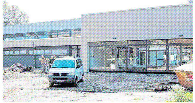
Die gemeinsam von Kreis und Stadt Bensheim gebaute neue Sporthalle des Alten Kurfürstlichen Gymnasiums könnte beispielhaft für die neue Halle der Eichendorff-Schule in Kirchhausen werden.
