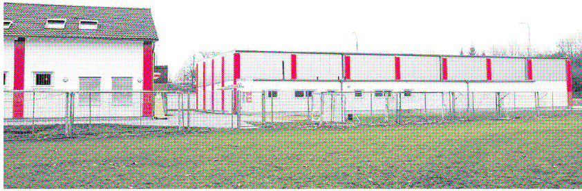
Kein Vorbild für Kirschhausen? Die Trainingshalle des TSV Auerbach hat nicht mehr als 800 000 Euro gekostet und wird als Beispiel dafür aufgeführt, dass Trainingsraum auch für wenig Geld zu haben ist. Landrat Matthias Wilkes (CDU) würde eine solche Halle allerdings „niemals bauen“, weil die Folgekosten zu hoch seien. BILD: KIEL
