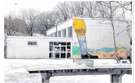
Die Sporthalle der Eichendorffschule in Kirschhausen ist marode. Die Heppenheimer CDU will nun, dass sich die Stadt an den Kosten eine größere Halle beteiligt. BILD: KÖPFFER
