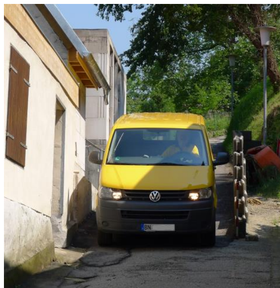
Erbisgasse Mai 2016 in Breite und Höhe gerade noch ausreichend für einen VW-Multivan b/h über alles: 2,30/1,97m. Links vorne beseitiger Dachüberstand, dahinter neuer in den Straßenraum ragender Dachüberstand mit Rinnenabgang.
